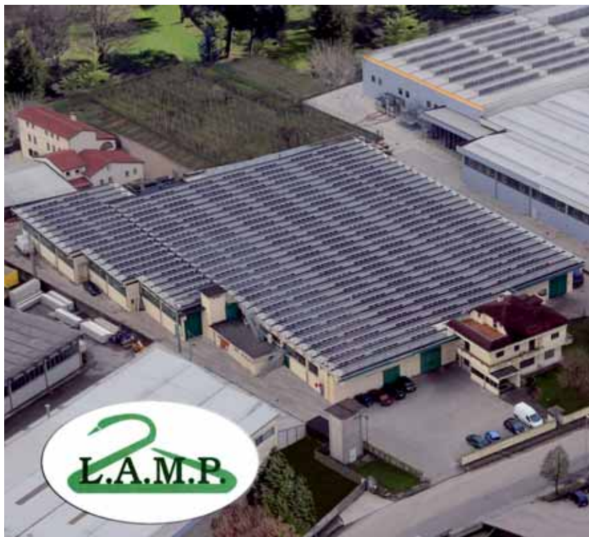
Foto aerea di un impianto fotovoltaico della LAMP
